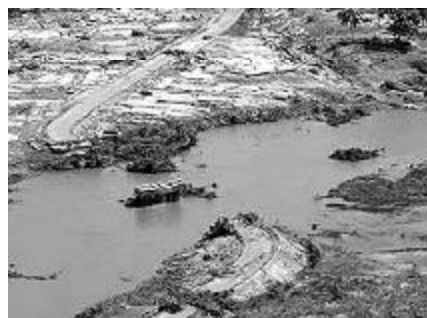
Fig. 48. Infraestructura de Banda Aceh afectada por el tsunami. Fuente: www.bbc.co.uk/portuguese/especial/
