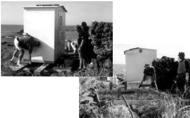
Fig. 49. Con apoyo del personal militar de Isla Socorro se trasladó la caseta de instrumentos a la cima oeste de la bahía Vargas Lozano. Isla Socorro. Fuente: CICESE
