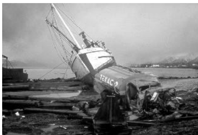
Fig. 19. Daños causados por el Tsunami en Alaska el 27 de marzo de 1964. Fuente: www.noaanews.noaa.gov/stories2005/images/alaska-tsunami-0327-1964.jpg
