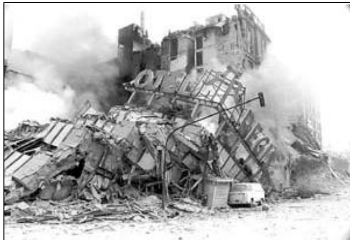
Figura 62. Colapso del hotel Regis de la Ciudad de México, a consecuencia del terremoto de 1985 (Fuente: Periódico La Jornada.)
