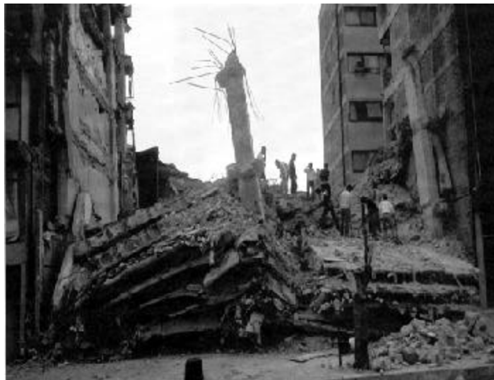
Figura 40. Aquí la columna de apoyo perforó, como un punzón, las losas de hormigón derrumbadas unas sobre otras. Ciudad de México 1985.
