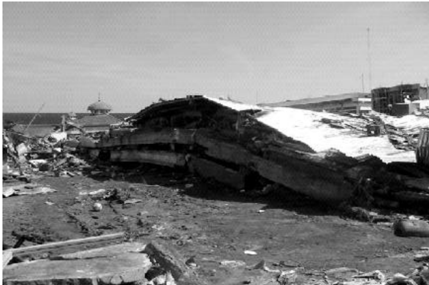
Figura 30. Colapso de una estructura de concreto en Banda Aceh, extremo norte de Sumatra, Indonesia
