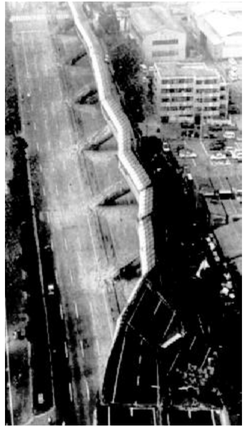
Figura 21. Colapso lateral del viaducto Hanshin, Japón, 1995.
