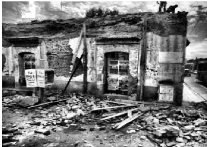
Figura 54. Daños a consecuencia del sismo del 30 de septiembre en Oaxaca, México
