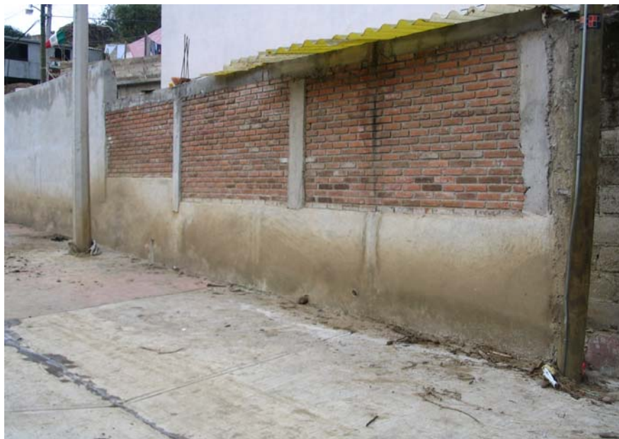
Figura 2.10 Barda construida en vivienda afectada en el 2001
