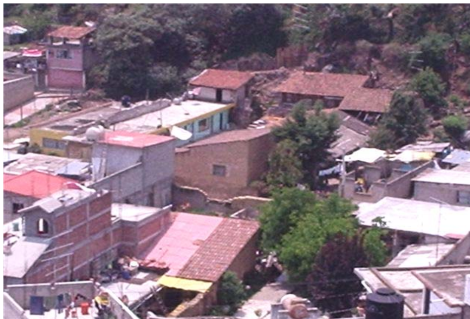
Figura 2.14 Viviendas de la localidad de Santa María Jajalpa
