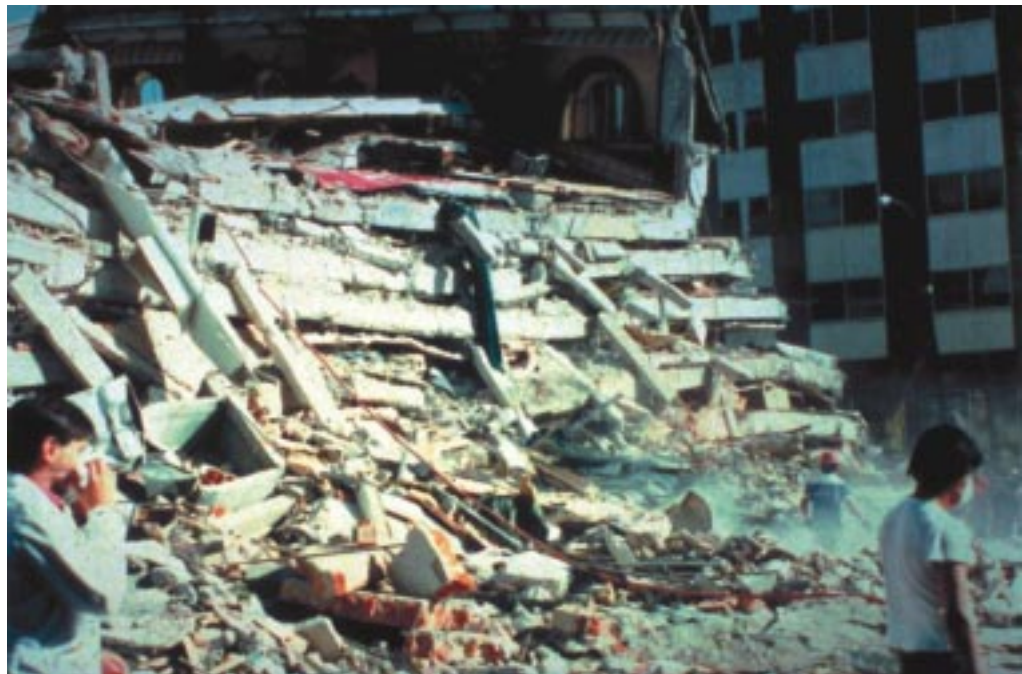
Figura 1. Colapso de edificio en la Ciudad de México durante el sismo de 1985
