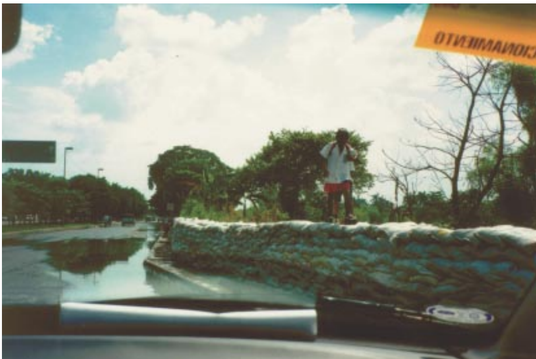
Figura 83. Obra de protección provisional en Villa Hermosa, Tabasco durante las inundaciones de 1999
