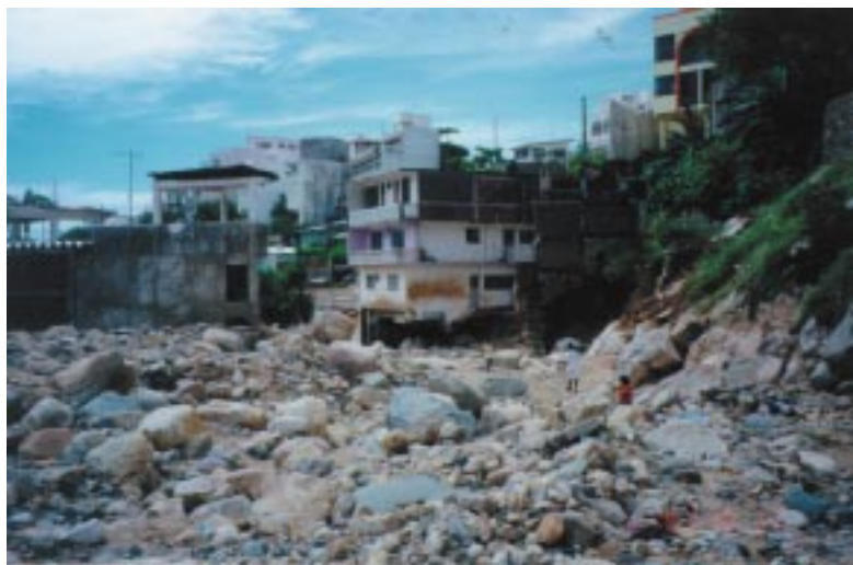
Daños causados por el huracán Pauline en la ciudad de Acapulco, el 9 de octubre de 1997.
