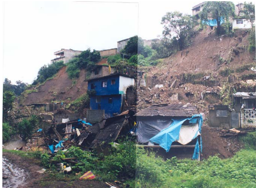
Figura 5.18 Vista de los deslizamientos y sus efectos en la colonia La Gloria
