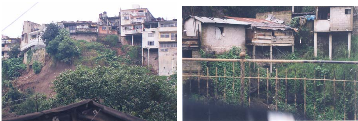
Figura 5.24 Viviendas en voladizo o con columnas de apoyo en las laderas de la colonia Benito Juárez
