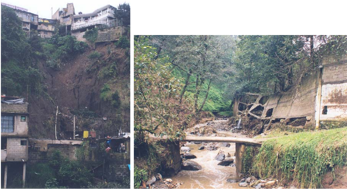
Figura 5.21 Destrucción de viviendas tanto por deslizamientos de laderas como por corrientes de agua en áreas aledañas al cauce del río Xoloco, Barrio Campo Verde
