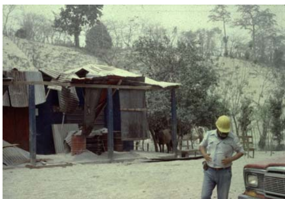
Figura 3.4 En regiones más cercanas al centro eruptivo, aparte de la ceniza volcánica, los fragmentos de mayor tamaño pueden producir perforaciones y severos daños a los techos, y a las vías de comunicación. Estas fotos muestran los daños producidos por las erupciones del volcán El Chichón en 1982, dentro de un radio de 10 km. A la izquierda, un techo perforado por líticos. A la derecha, un puente semidestruído por impactos. Fotos de S. De la Cruz
