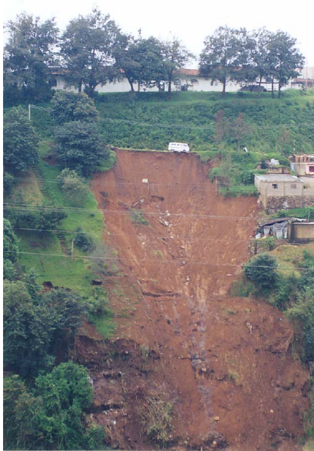
Figura 5.26 Vista frontal del deslizamiento contiguo a la carretera Perote-Teziutlán, en el tramo que cruza el barrio Xoloco
