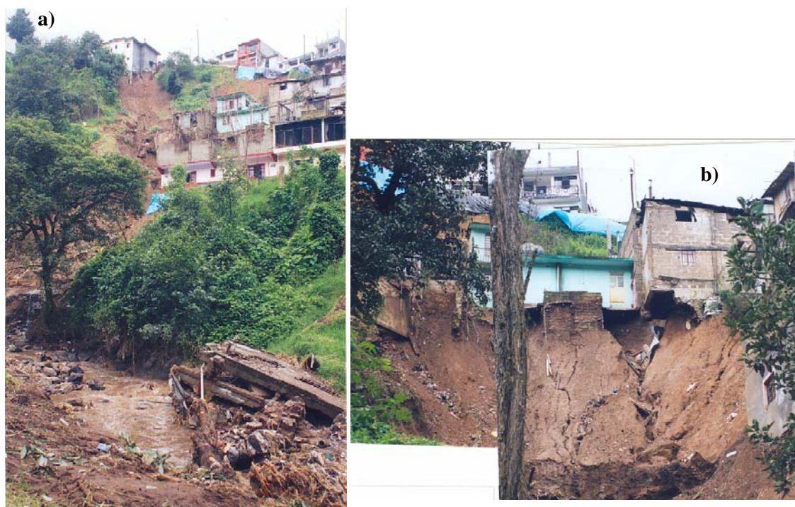
Figura 5.22 Destrucción de viviendas por los deslizamientos ocurridos en la Col. Benito Juárez
