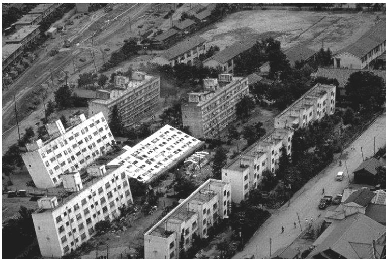
Figura 1.4 - Edificios inclinados por licuación de arenas
